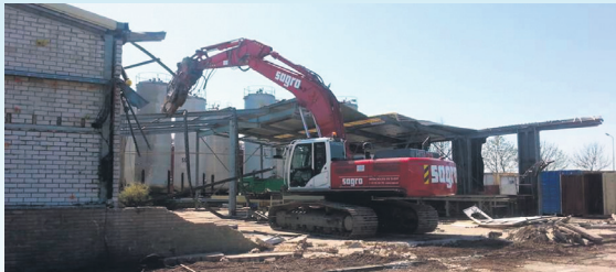
Sagro aan de slag met sloop van chemiebedrijf Caldic.
