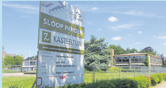
Vorige week zijn het bouwbord en de bouwhekken geplaatst.
